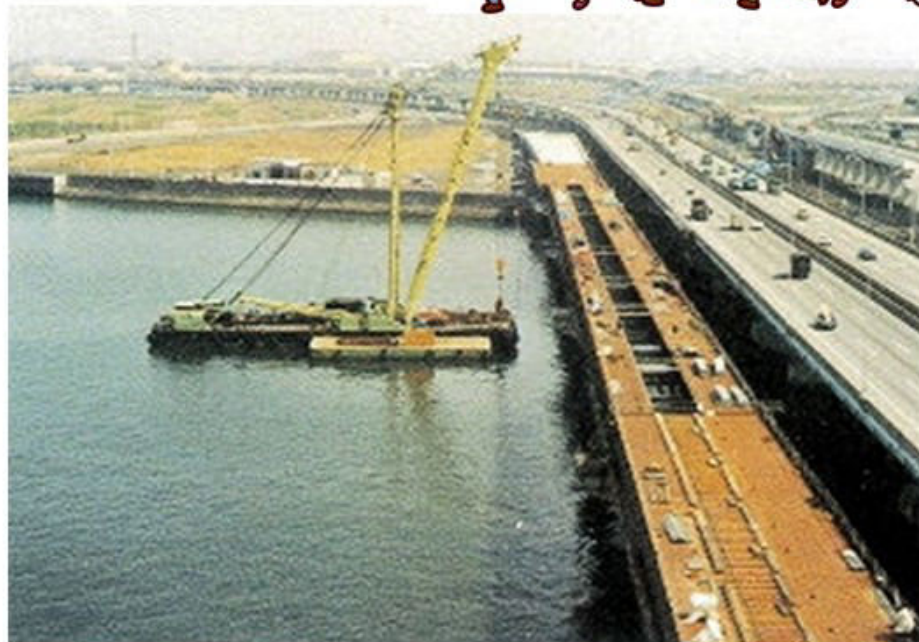
国道357（湾岸道路）の建設。写真／首都国道事務所
